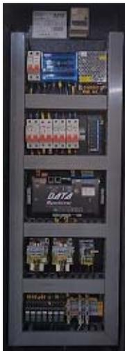
•**Supresor de Picos:** La unidad posee protección contra tensiones transitorias de 2° nivel,  $I_n \geq 20$  kA,  $V_p < 1,4$  kV, curva 80/20ms, con protección contra sobre corrientes incluida.
